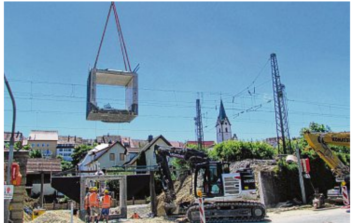
... und in Millimeterarbeit zwischen den Drähten der elektrischen Oberleitungen hindurch an seinen Platz manövriert.
