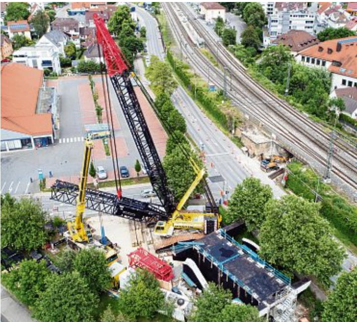
Aus der Vogelperspektive gut zu erkennen: Rechts steht noch die »alte« Ballenberg-Bahnbrücke, auf der gegenüberliegenden Straßenseite wurden die neuen Brückenteile vorgefertigt. Bild: Häufle
