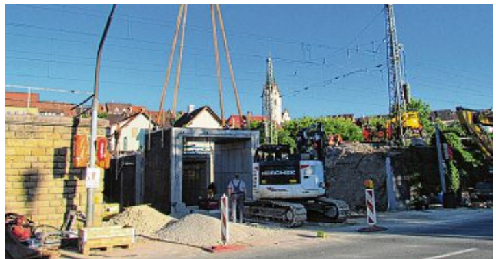
Rahmenteil für Rahmenteil aus Stahlbeton in unterschiedlichen Größen und mit unterschiedlichem Gewicht (das schwerste Teilstück wog 250 Tonnen) wurde eingesetzt und miteinander verspannt. Ab dem Wochenende soll die Bahnstrecke wieder befahrbar sein. Bis Fahrzeuge durch die neue Unterführung fahren können, braucht es noch Zeit. Laut Deutsche Bahn sollen die Restarbeiten des Großprojekts, dessen Gesamtkosten mit 3 Millionen Euro angegeben werden, im September abgeschlossen sein. Bilder: Hering
