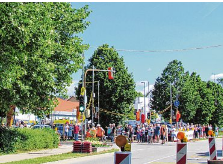
Die Kreuzung Hegastraße/Ballenbergstraße war am Montag den ganzen Tag über Anziehungspunkt für viele Engener Bürgerinnen und Bürger, die sich höchst beeindruckt zeigten, wie sorgfältig, aber auch routiniert die diffizilen Arbeiten ausgeführt wurden.
